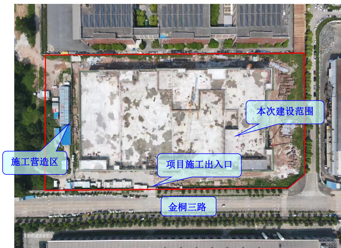
照片1 项目整体施工现状
