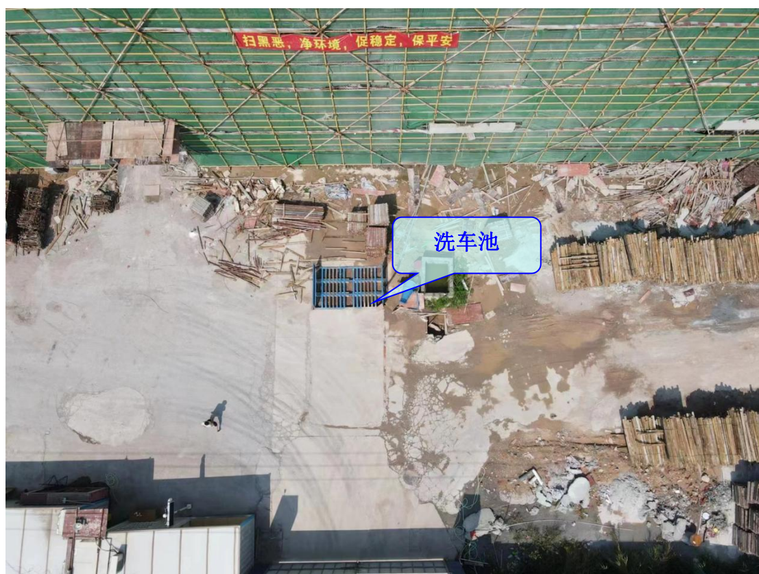
照片2 项目区施工出入口及洗车池
