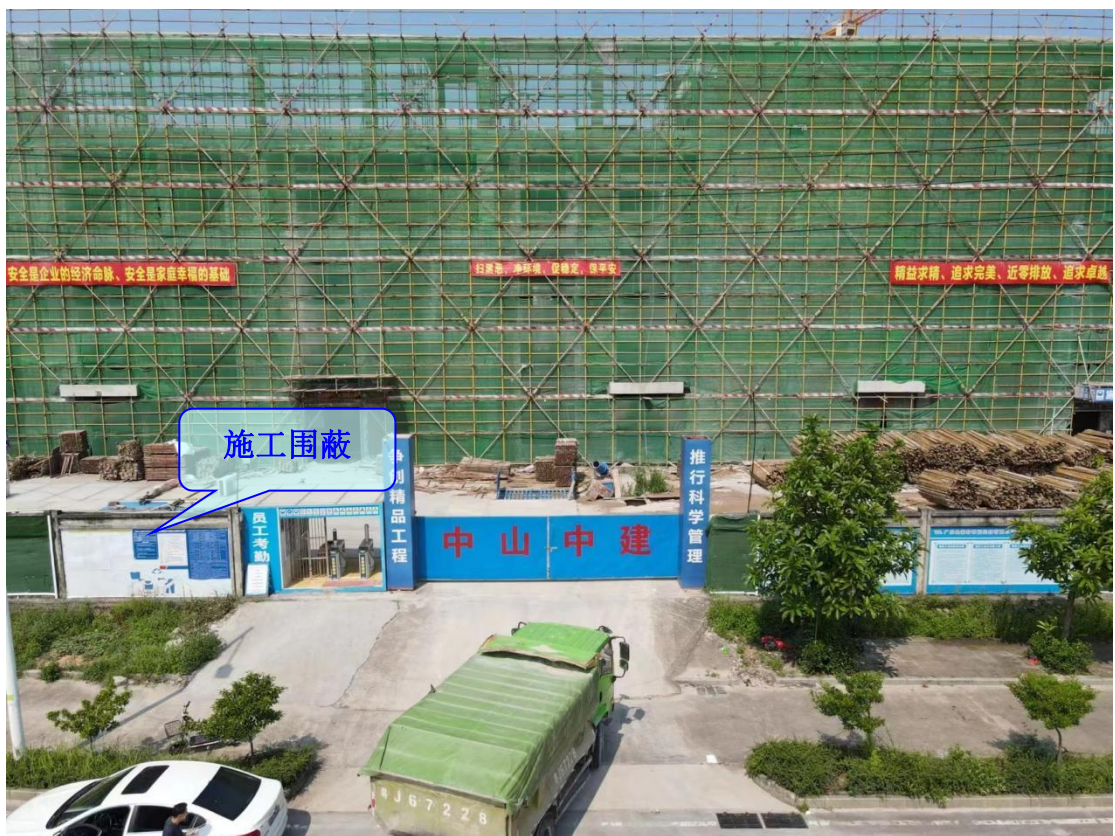
照片3 项目施工出入口
